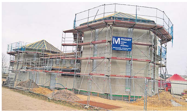
Das neue Gebäude des Cabuwazi nimmt zunehmend Gestalt an
